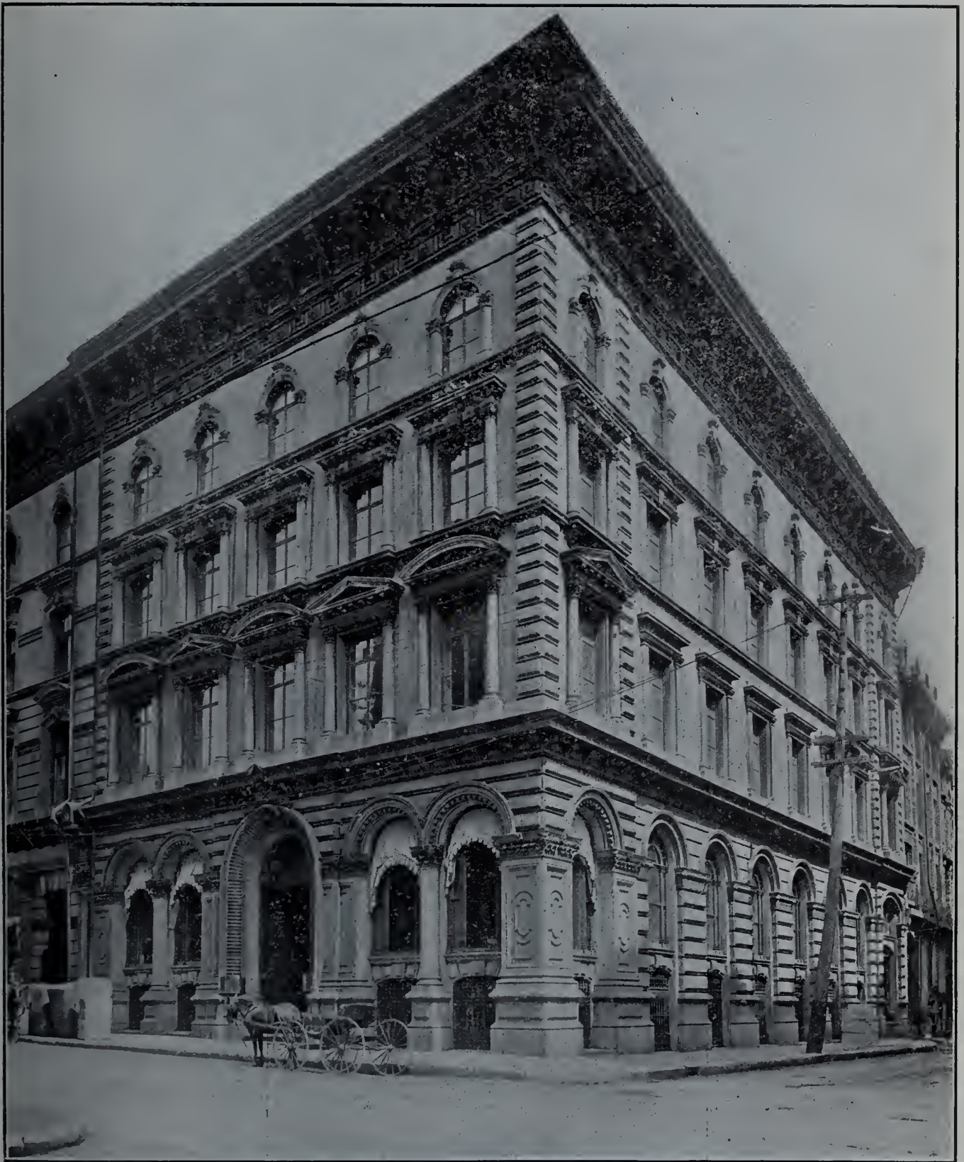
Magasins et Entrepôts à l'angle des Rues Ste-Hélène et des Récollets, MONTREAL.
