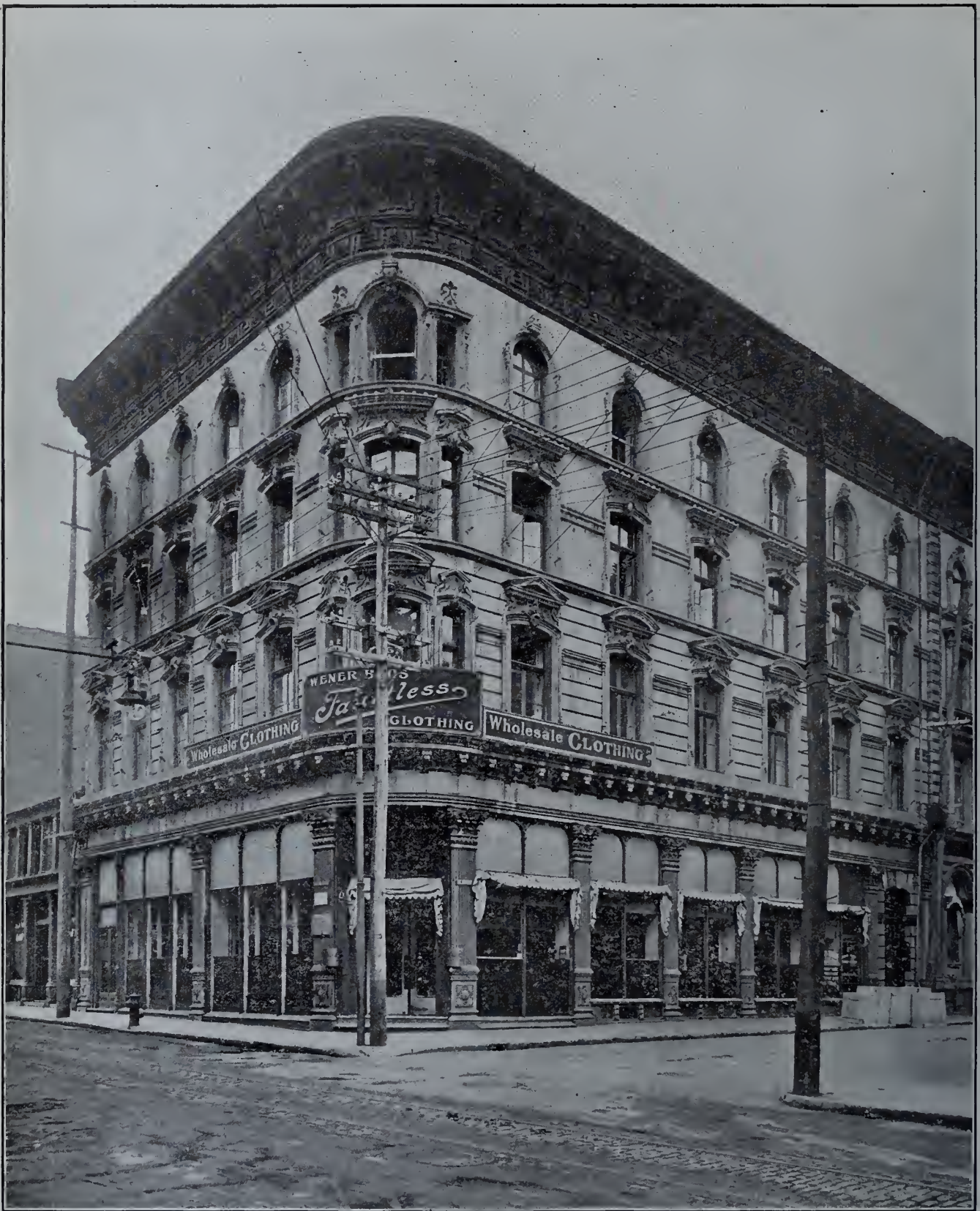
Magasins et Entrepôts à l'angle des rues Notre-Dame et Ste-Hélène, MONTREAL.
