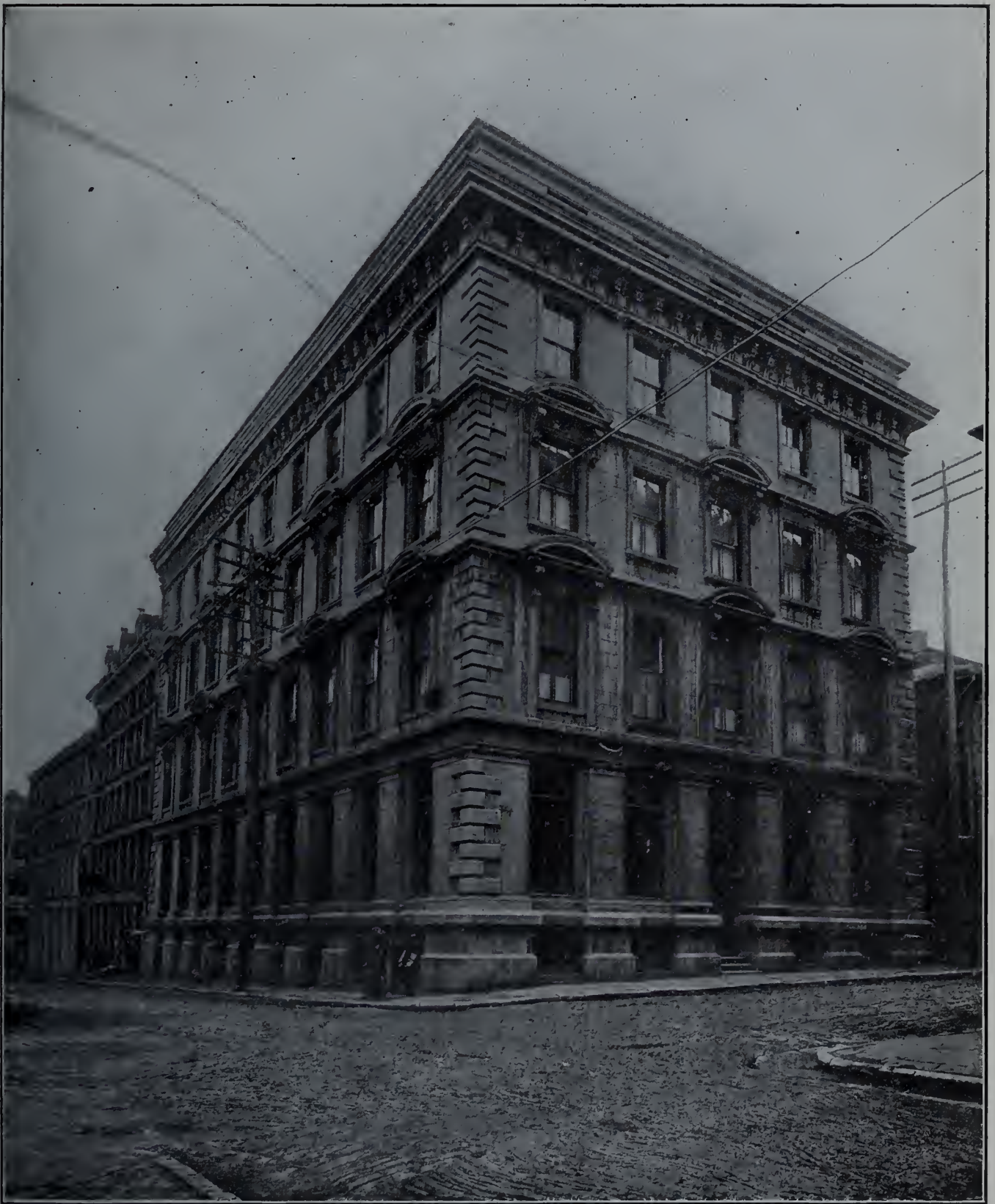
ENTREPOT ACTUEL DE THE W. R. BROCK COMPANY (Limited) A l'angle des Rues Ste-Hélène et des Récollets MONTREAL
